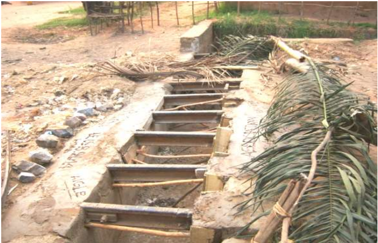
Passerelle en réhabilitation, sur fonds propre des communautés de base du quartier Lubuwa, dans la Commune de Ndesha [Photo RRSSJ]
